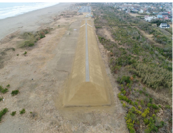
盛土工事完了
